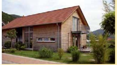
Die Bauherren legten hohen Wert auf die Verwendung natürlicher Materialien in ihrem Wohnumfeld. So fiel die Wahl des Baustoffs für die Tragkonstruktion auf Leno-Massivholz, ein Produkt aus heimischem Holz, dass das Raumklima positiv beeinflusst. Auch das Äußere des Gebäudes wird vom Charakter des Holzes bestimmt. In harmonischem Gleichklang wurde sowohl für die Fassade als auch für den Terrassenbelag das besonders dauerhafte und widerstandsfähige Holz der Douglasie ausgesucht.
