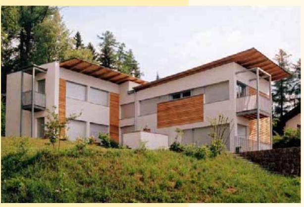
Nachdem sich die Bauherren durch die Erfahrung bei einem anderen Objekt von den Vorzügen der Holzbauweise überzeugen konnten, entschieden sie sich bei diesem Vorhaben schon vor der Planung für die ökologische und energiesparende Bauart. Die tragende Konstruktion aus Massivholz wird mit guter Wärmedämmung ausgestattet und konnte so, wahlweise mit Putz, Anstrich oder Holzverschalung versehen, eine interessant und ausgewogen gestaltete Fassade bilden.
